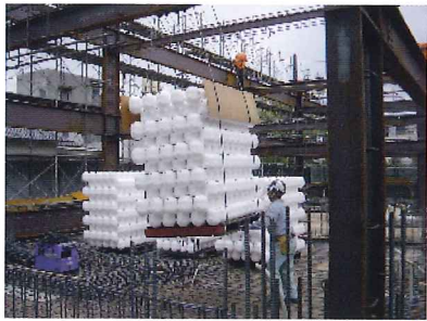
中空材ユニット荷揚げ
