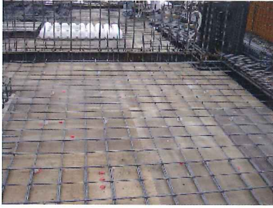
インサート配置→下筋
