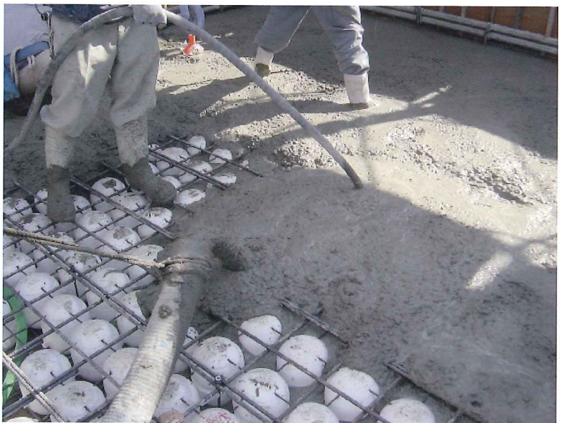
コンクリート打設状況
