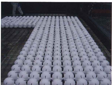
中空材敷設状況
