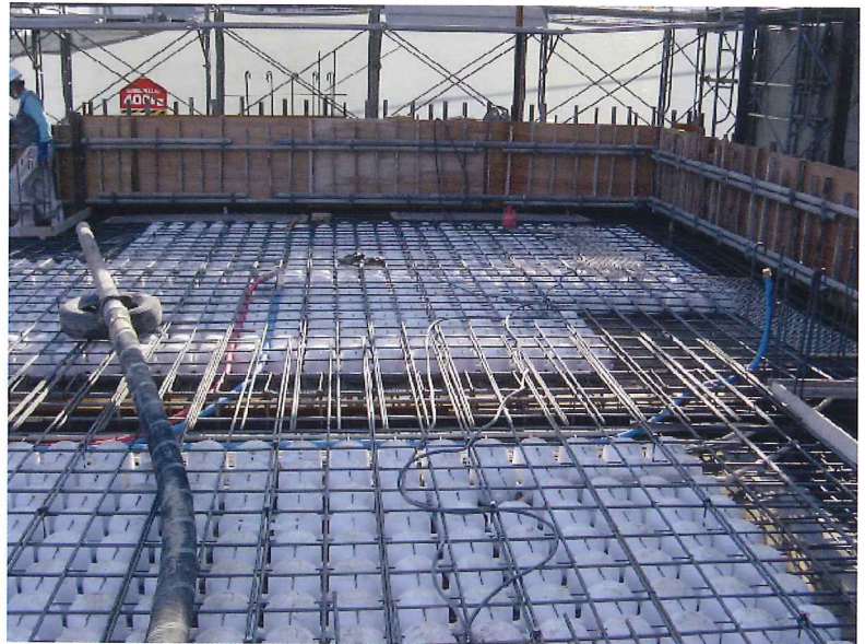
配筋完了・コン打ち前状況
