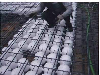
上筋配筋作業
